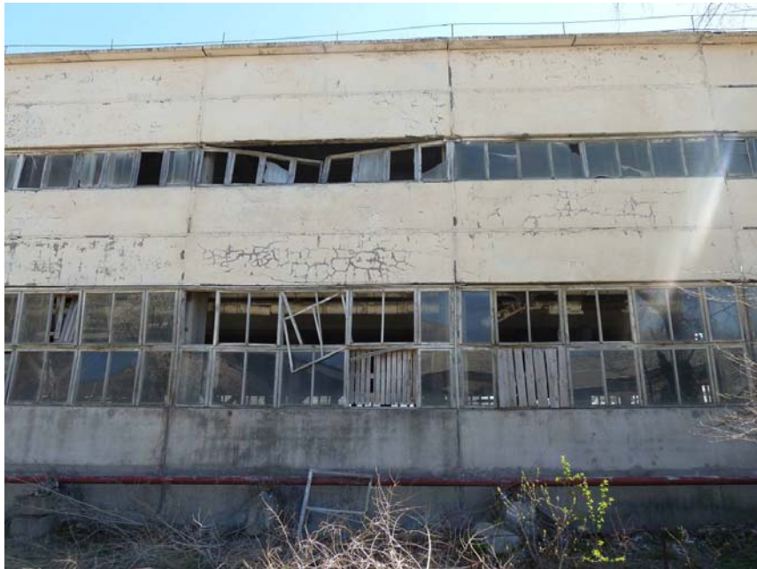
Рисунок 1 – Загальний вигляд формувального цеху заводу ЗБВ в м. Світловодськ
