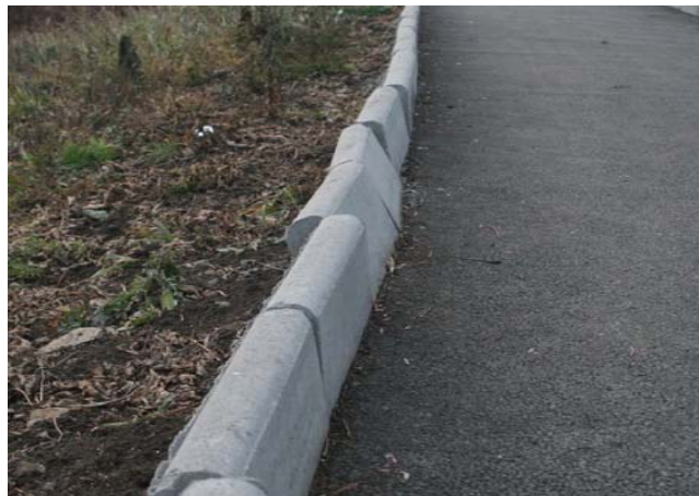
Рисунок 8 – Зміна взаємного положення бордюрів один відносно одного в процесі експлуатації
