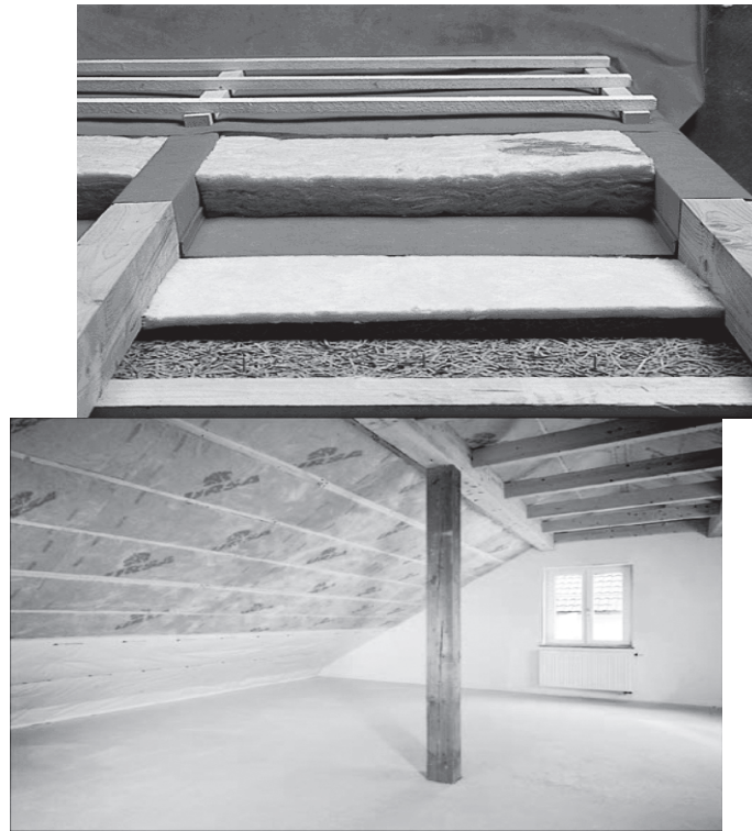
Рисунок 1- Размещение теплозвукоизоляционного материала в стропильной системе
