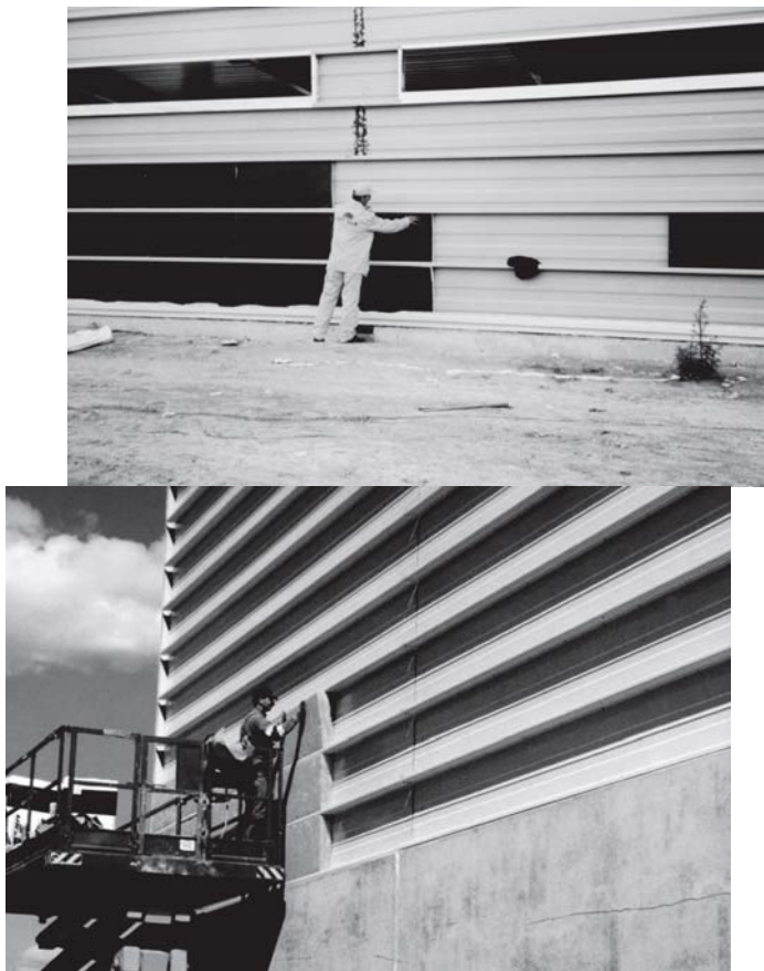
Рисунок 2 – Размещение теплоизоляционных плит в кассетах.
