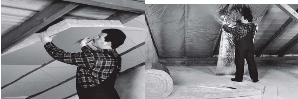
Рисунок 2 – Монтаж алюминиевого теплового экрана
