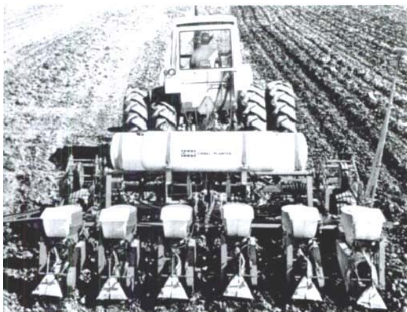
Рисунок 2 – Чизельна сівалка «Chisel Planter», розроблена Дж. І. Кейсом
