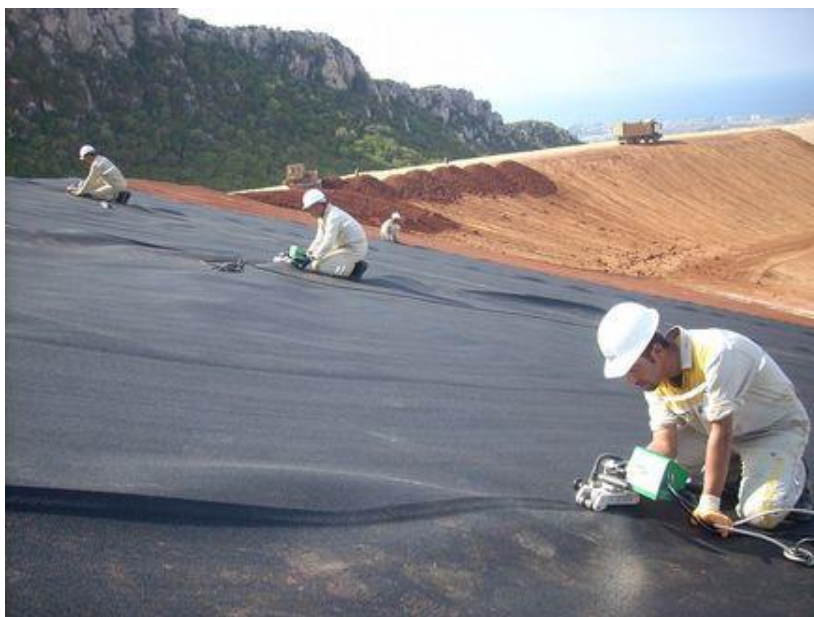
Рисунок 8 - Зварювання швів дренажного полімерного екрану
