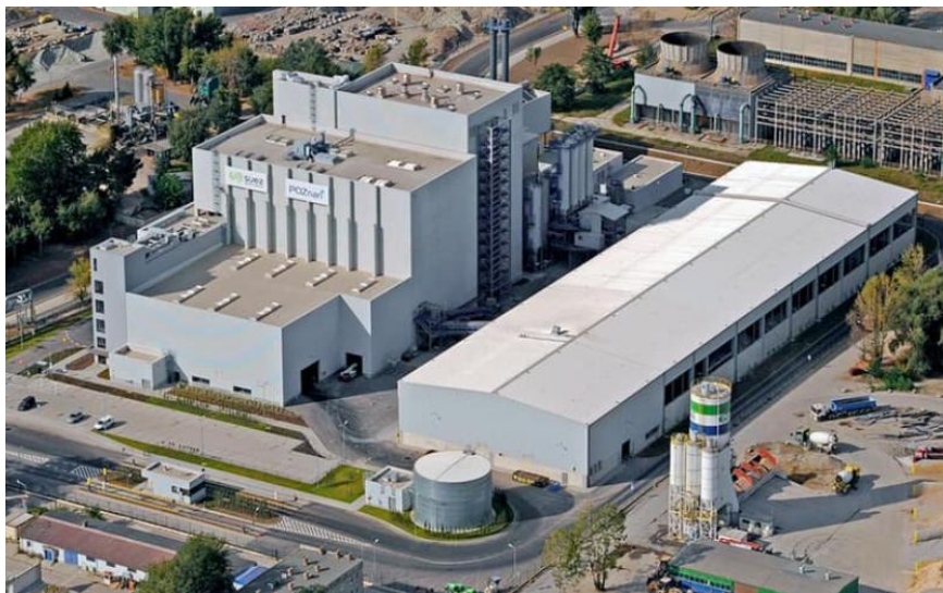
Рисунок 22 - Сміттєспалювальний завод ITPOK Poznań у м. Познань
