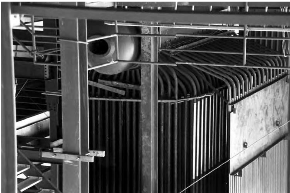
Рисунок 20 - Труби, які екранують стінки парогенератора та забезпечують відбір теплової енергії від продуктів згорання
