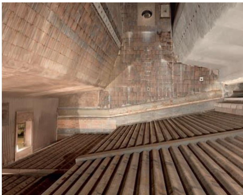
Рисунок 17 - Вигляд колосникової решітки всередині топочного агрегату
