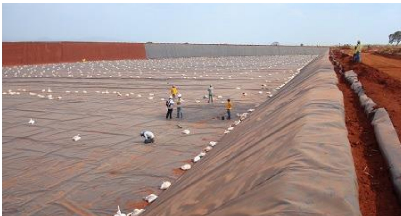
Рисунок 7- Підготовка ділянки сучасного полігону для захоронення відходів
