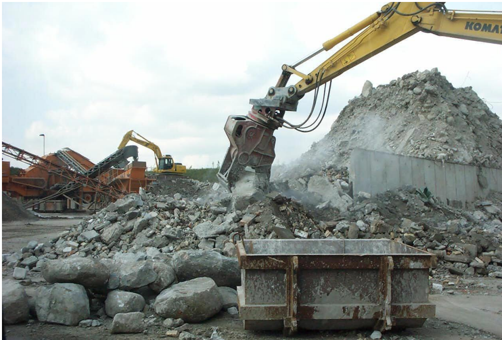
Рисунок 193 - Гідравлічний екскаватор, оснащений гнучким багатоцільовим інструментом
