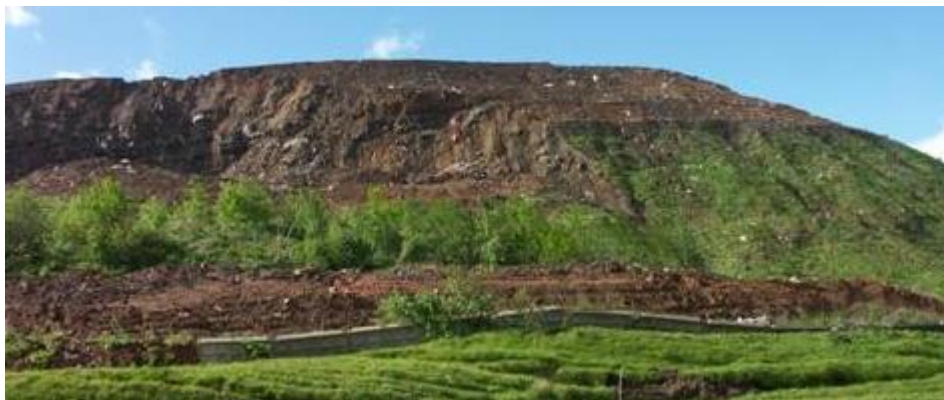
Рисунок 12 - Руйнування бокових укосів полігону, який було рекультивовано з порушенням технології
