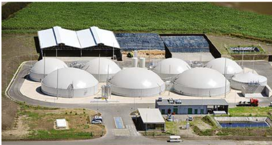
Рисунок 109 - Біогазовий завод в Угорщині потужністю 4 МВт, здатний переробляти до 90 000 т органічних відходів
