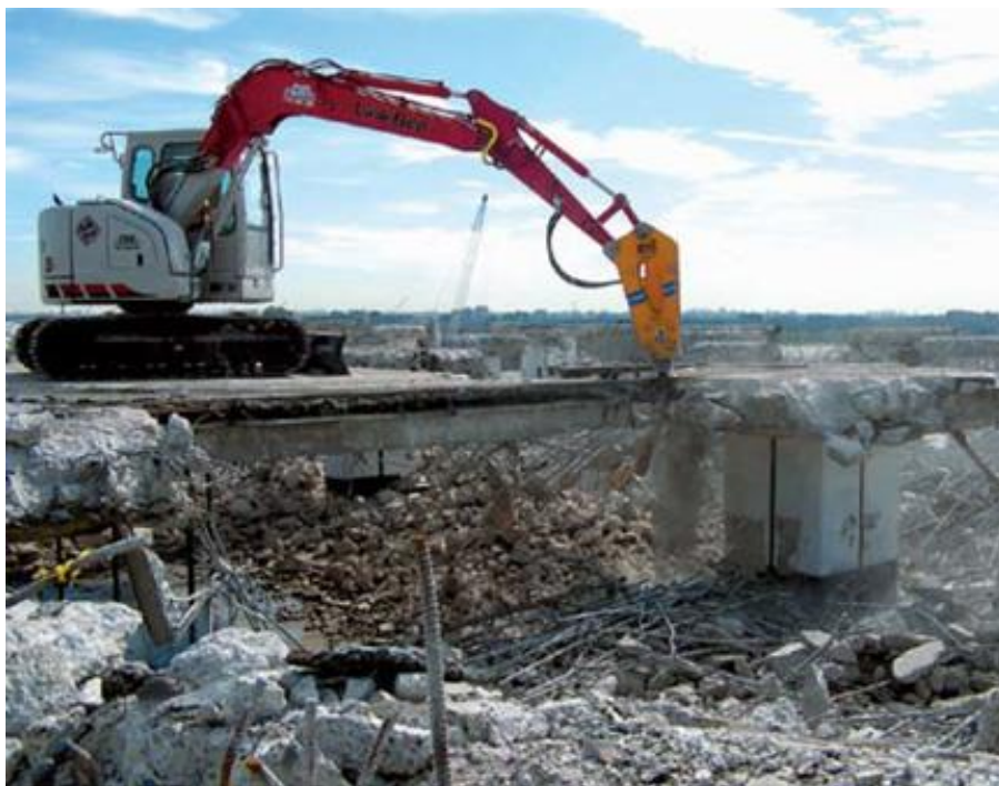
Рисунок 194 - Гідравлічні ножиці, які здатні різати арматуру і бетон, захоплювати і переносити відрізані частини будівлі
