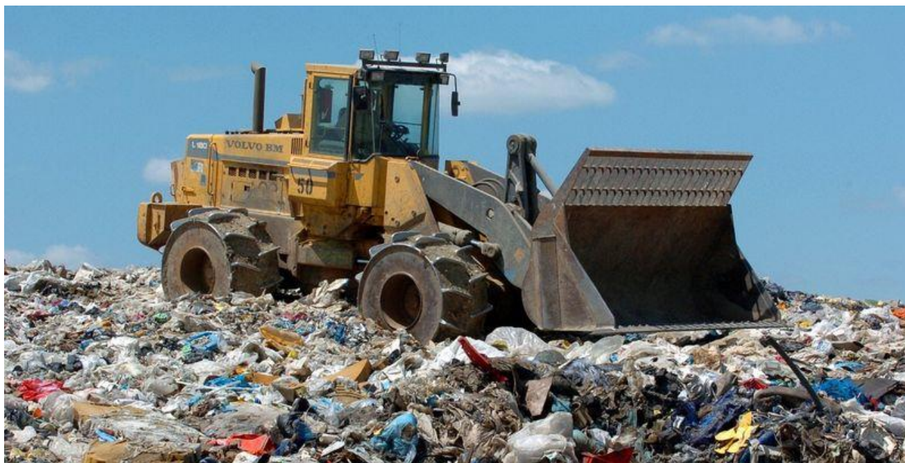
Рисунок 10 - Ущільнення на полігоні шарів твердих побутових відходів
