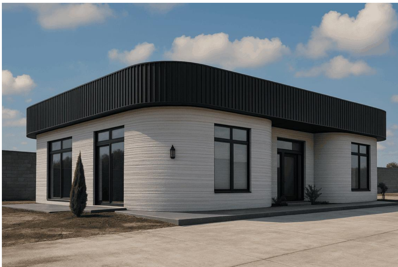
Рисунок 199 – Бетонна будівля, яка споруджена методом 3D-друку
