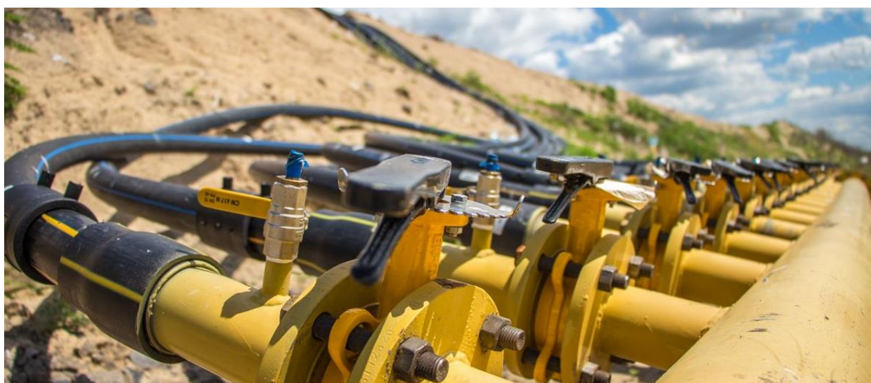
Рисунок 114 - Збір звалищного газу від свердловин в колектор
