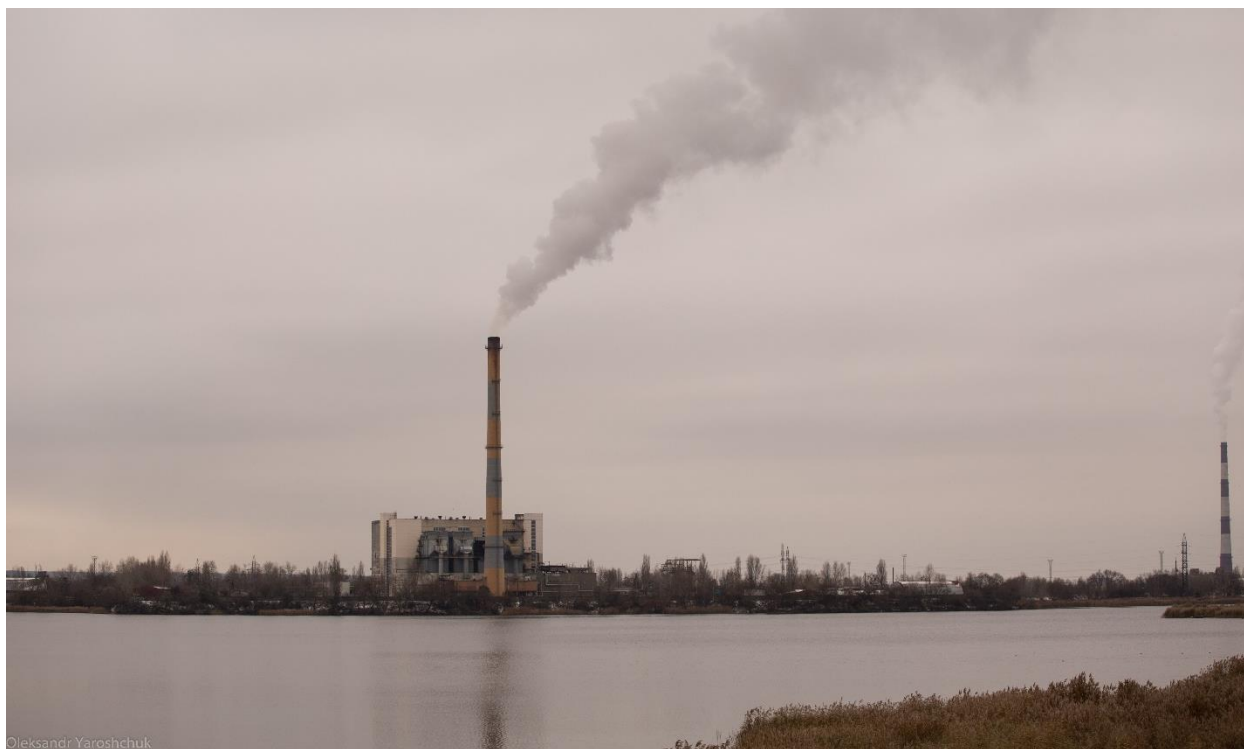
Рисунок 30 - Загальний вигляд заводу «Енергія» з боку проспекту Бажана. На передньому плані – озеро Вирлиця
