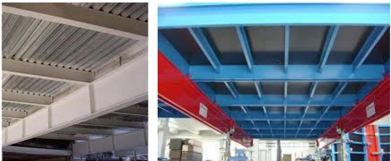
Рис. 1.4 Балкові клітки нормального та ускладненого типу
