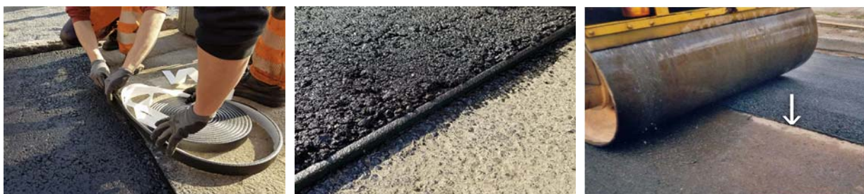
Рисунок 2 – Застосування самоклеючих бітумно-полімерних стикувальних стрічок Джерело: [1, 5]
