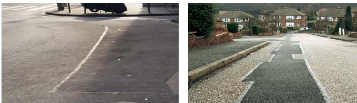
Рисунок 3 – Стан бітумно-полімерних стикувальних стрічок після тривалої експлуатації Джерело: [1, 5]
