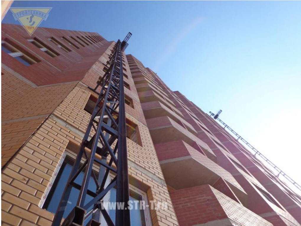
Рис.1.3. Щогловий підіймач на зведенні житлового будинку
