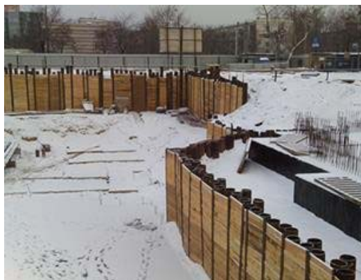
Рисунок 3 – Огородження котловану зі сталевих елементів із забиркою
