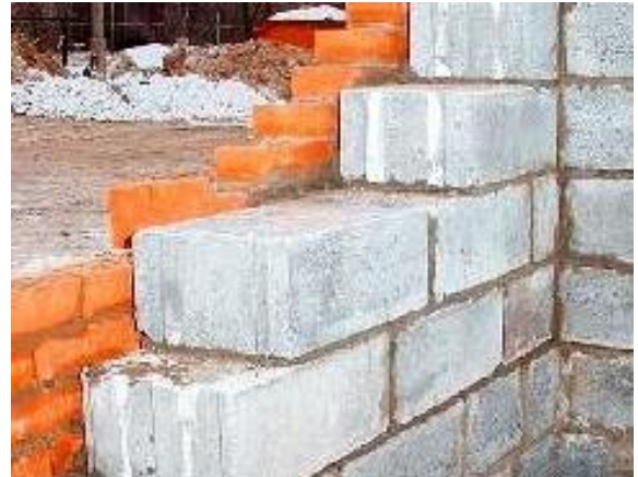
Рис. 1.5 Двошарові стіни з блоків ніздрюватого бетону та лицьової цегли
