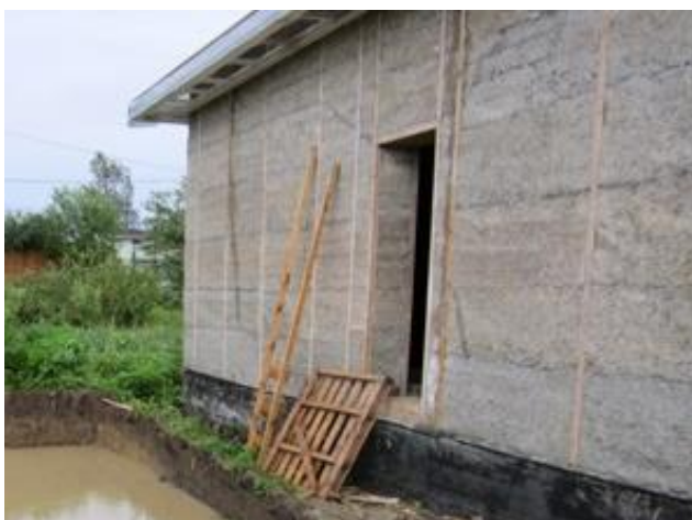
Рис. 1.9 Стіна з монолітного ніздрюватого бетону
