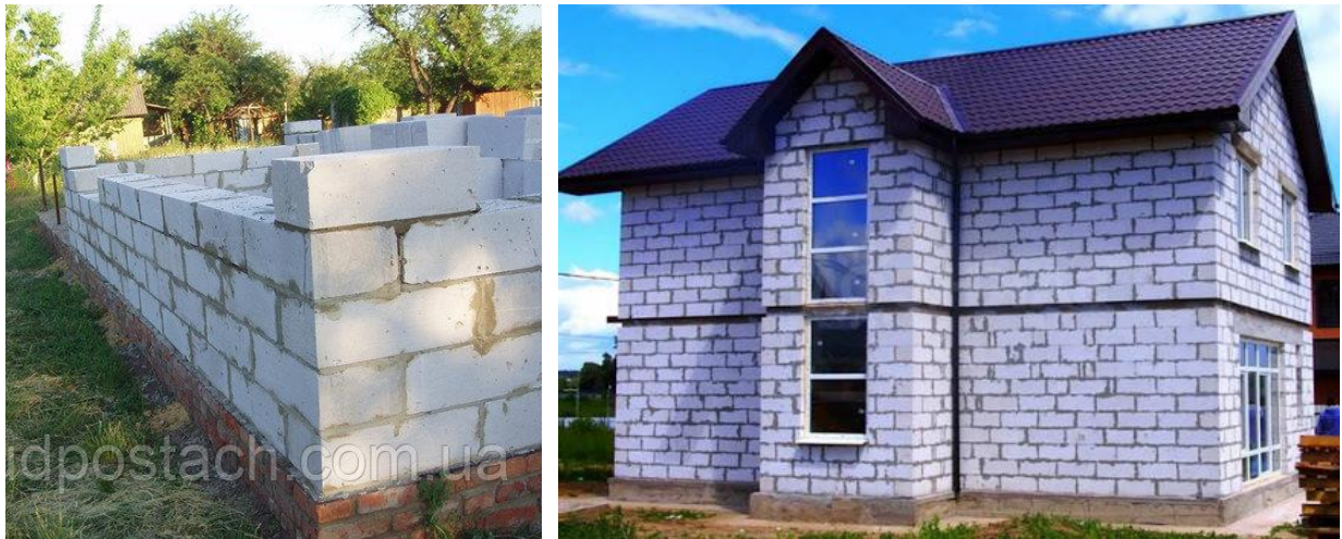
Рис. 1.3 Загальний вигляд одношарових стін з блоків ніздрюватого бетону
