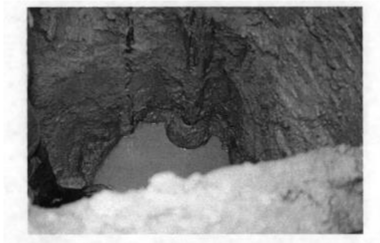
Рис. 2.17 Мікропалі з втрамбованому розширенню в обводненому ґрунті.
