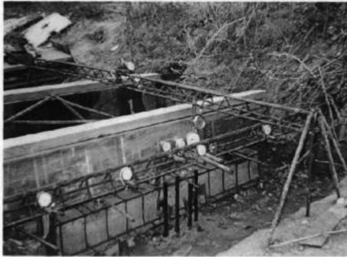
Рис. 3.7 Встановлення прогібомірів на репери.
