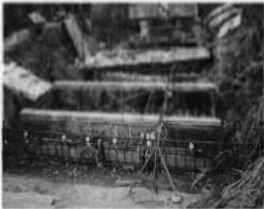
Рис. 3.2 Стрічковий пальовий фундамент з низьким розтверком.
