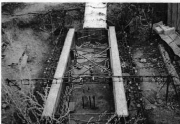
Рис. 3.6 Стрічковий фундамент з низьким розтверком до навантаження.
