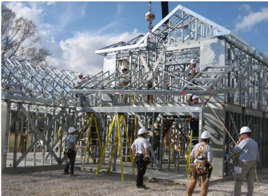
Рисунок 2 – Монтаж каркасу будівлі за технологією «Genesis»
