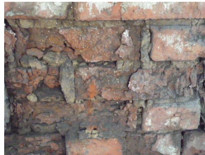
Рис.5 Структурне руйнування мурування сольовими сполуками.
