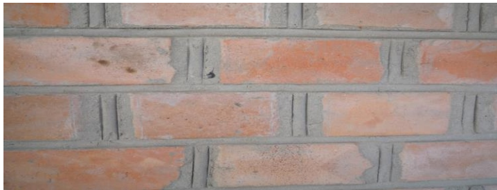
Рис. 4 Заповнення швів між штучними облицювальними елементами фасаду згідно традиційної технології заповнення.
