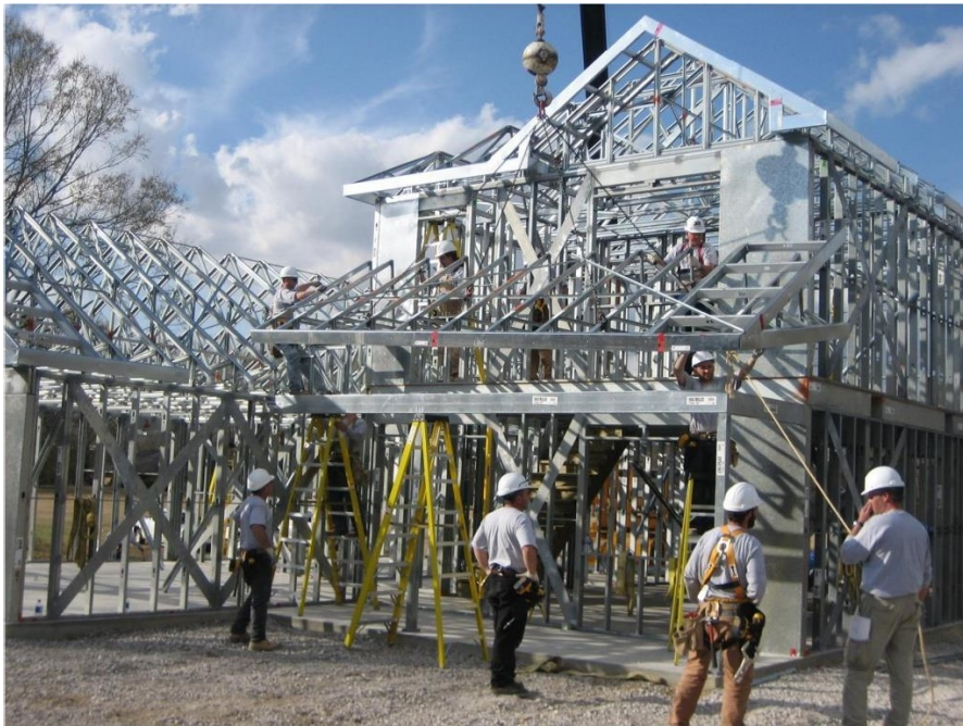
Рисунок 2 – Монтаж каркасу будівлі за технологією «Genesis»
