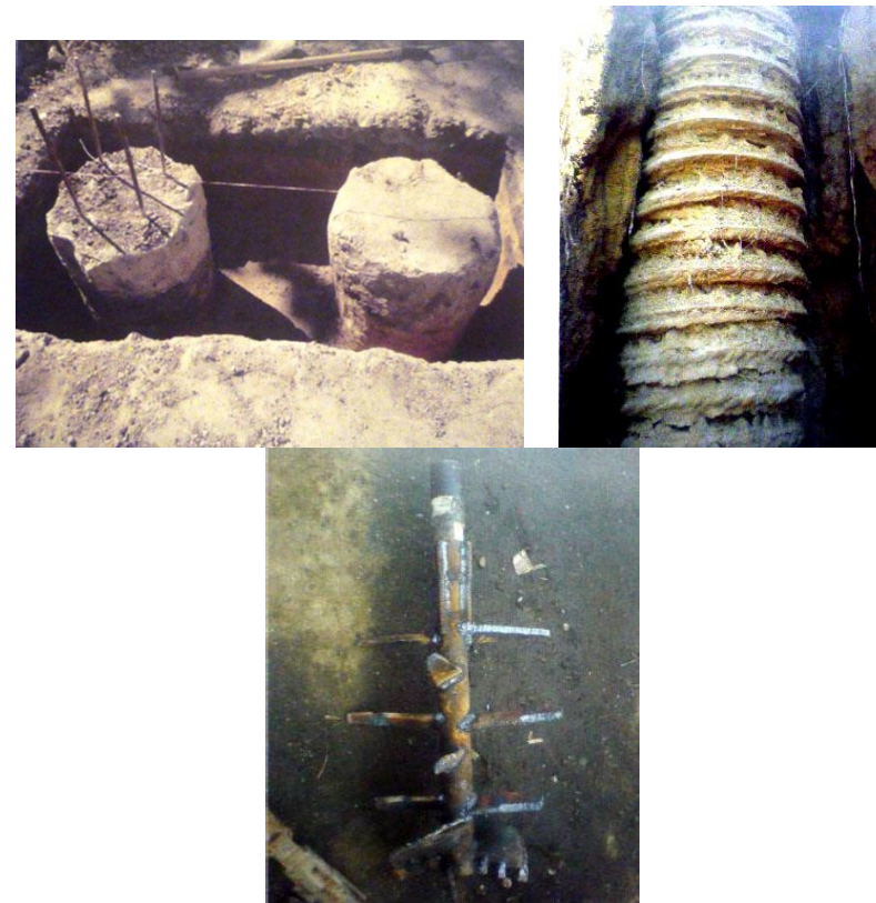
Рис.2. Натурні вертикальні зразки ґрунтоцементних елементів, виготовлених за бурозмішувальною технологією та конструкція змішувально-бурового елемента.
