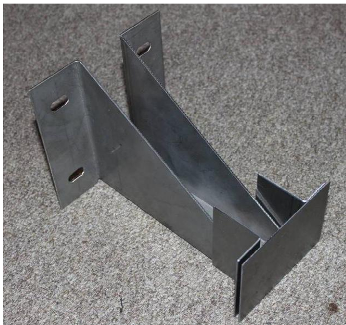
Рисунок 20 – Несучий кронштейн, куточки кріплення пластини та пластина кріплення кляммера у зборі (перевернуто)
