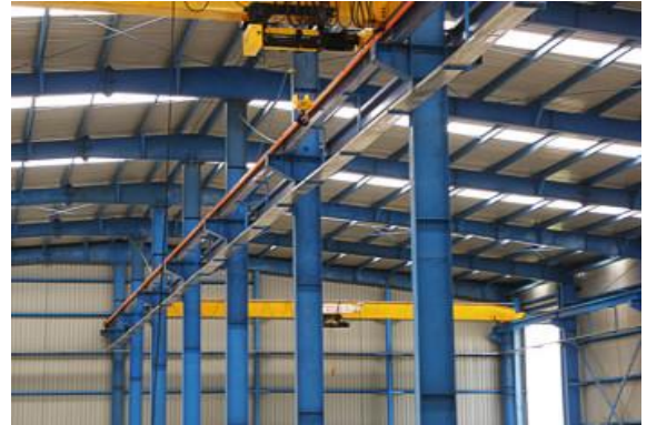
Рис.1.6 Рейкові колії мостових кранів
