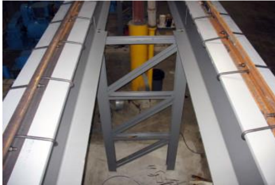
Рис.1.6 Рейкові колії мостових кранів
