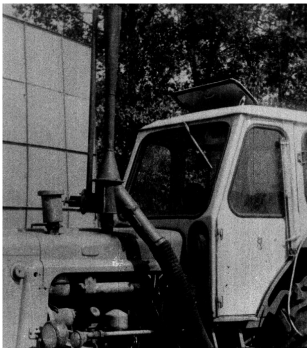
Рис. 2.3. Газоструминневий компресор сівалки СУПН 8-01
