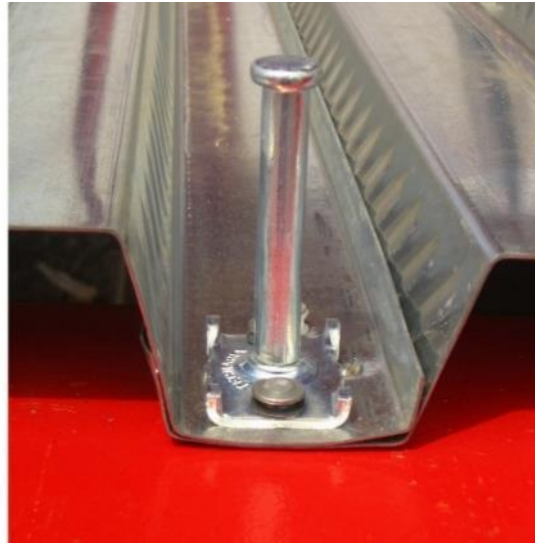
Рисунок 10 – Загальний вид анкерного упору Tecnaria CTF Connector
