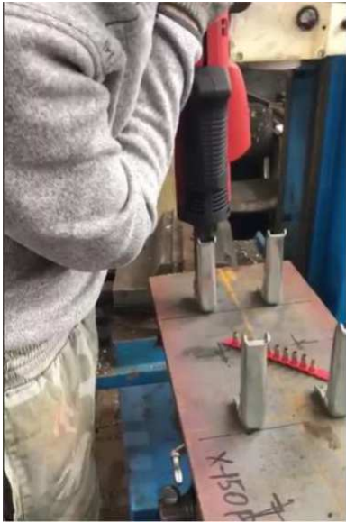
Рисунок 30 – Монтаж кутових анкерних упорів
