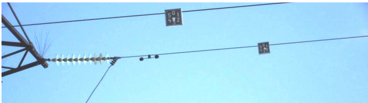
Рисунок 2 – Розміщення ФКЗ на лінії електропередачі
