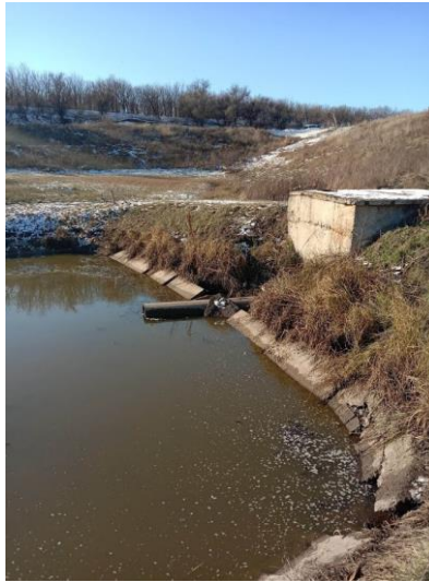
Рис. 2.4. Перепускна труба зі ставу №3 діаметром 1 м (діюча за функціональним призначенням)
