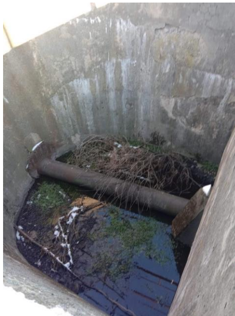
Рис.1.3. Страхувальний водоскидний колодязь зі ставу №3 з сталевією перепускною трубою діаметром 0,8 м (за час експлуатації ставу не використовувалась за призначенням)
