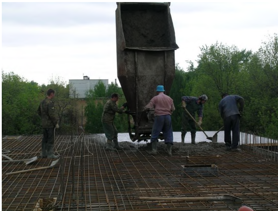
Рисунок 3.4 – Ущільнення бетонної суміші глибинним вібратором
