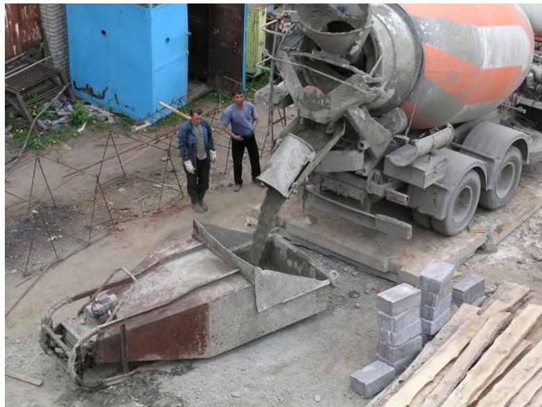
Рисунок 3.3 – Процес укладання бетону за допомогою крана Liebherr LTM 1070-4.2
