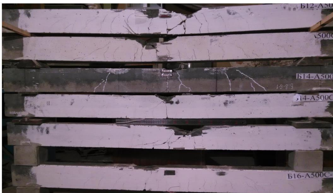
Рисунок 2.18 - Вигляд зруйнованих балок з арматурою А500 діаметром 12, 14 і 16 мм
