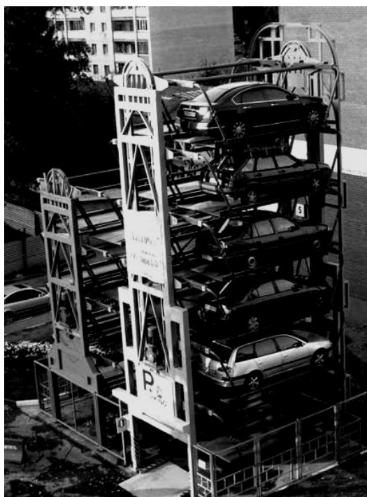
Рисунок 1.2 – Загальний вигляд автоматичного модульного паркувальника
