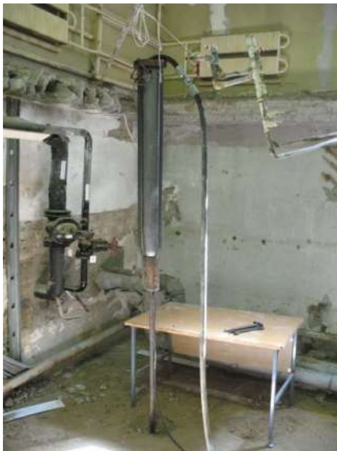
Рисунок 2.19 Занурення зонда під дією встановленого на нього пневмопробійника.
