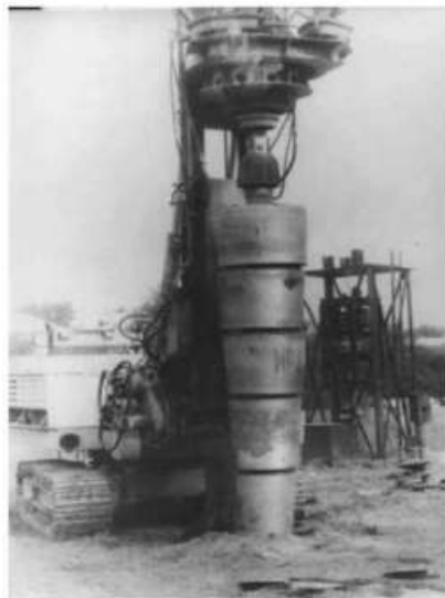
Рисунок 2.4- Розкочувач свердловин а) - зразок 1967р.; б) - зразок 2008р.
