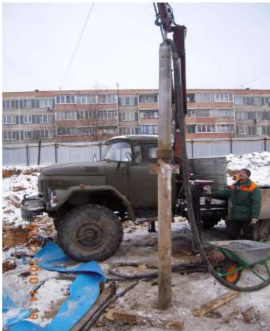
Рисунок 2.8 – Виконання робіт з виготовлення щебеневих елементів з обсадною трубою.
