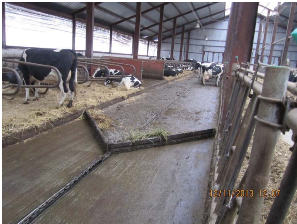
Рисунок 1 – Скреперна установка для прибирання гною УС-80
