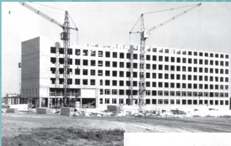
Будівництво навчального корпусу КІСМу
