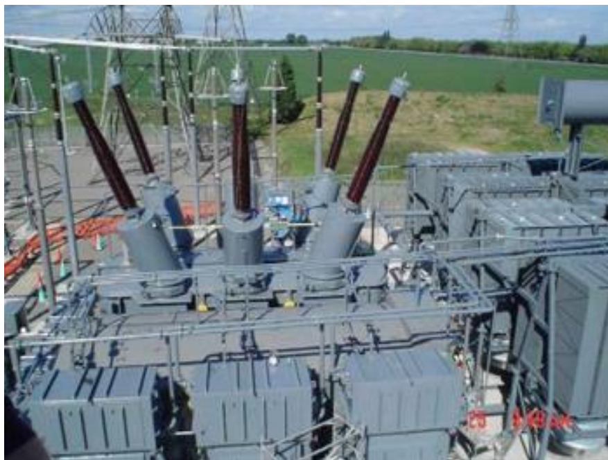
Рис. 3.1.5 – Фазоповоротний трансформатор
