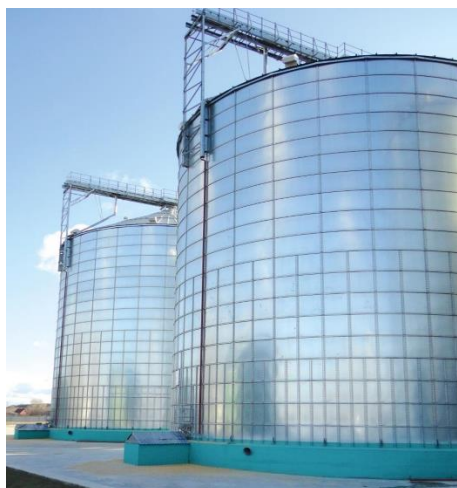
Рис. 1.2 – Великотонажний циліндричний металевий силос для зберігання зерна
