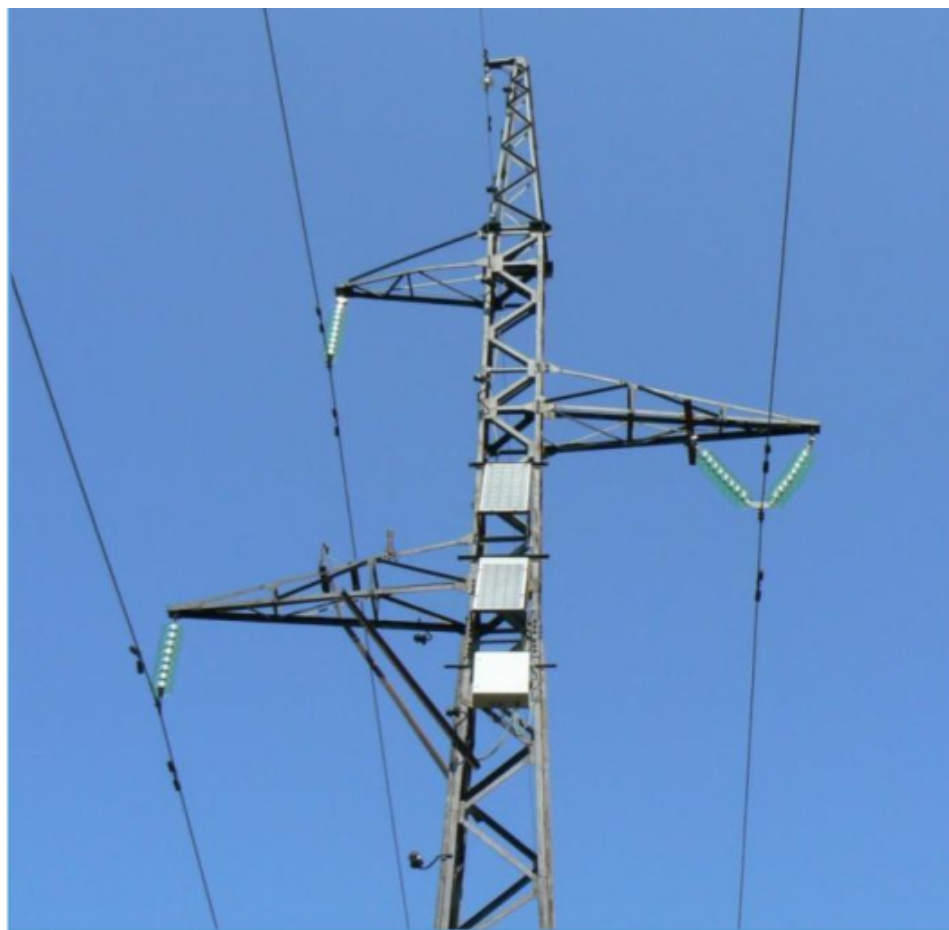
Рисунок 3.10 – Y-подібний підвіс проводу ПЛЕ 110 кВ
