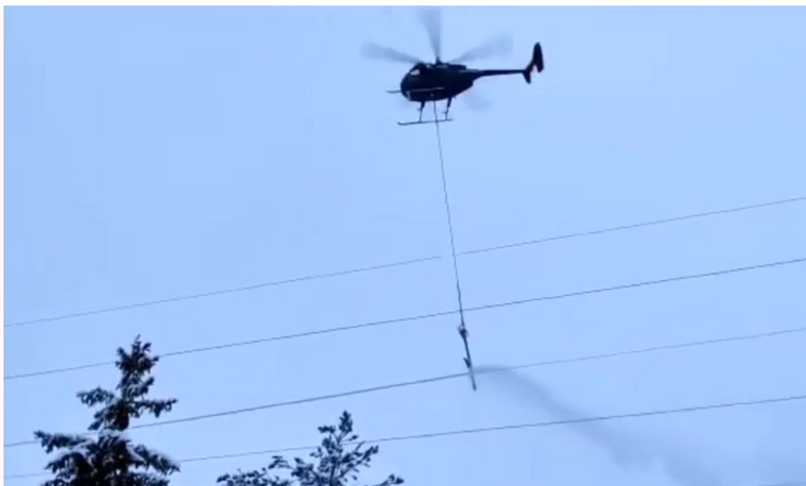
Рисунок 1.6 – Очищення проводу ПЛЕ від ОПВ за допомогою гелікоптера
