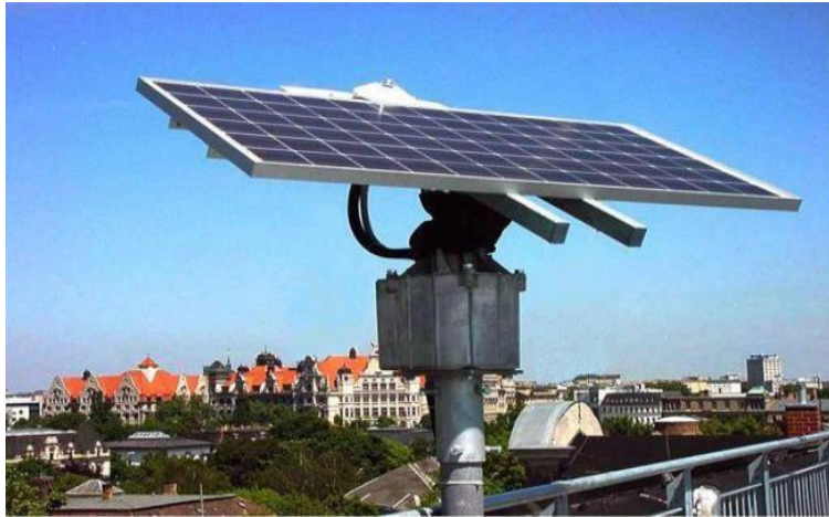
Рисунок 1.2 – Установка фотоелектричної панелі зі слідкуванням за Сонцем
