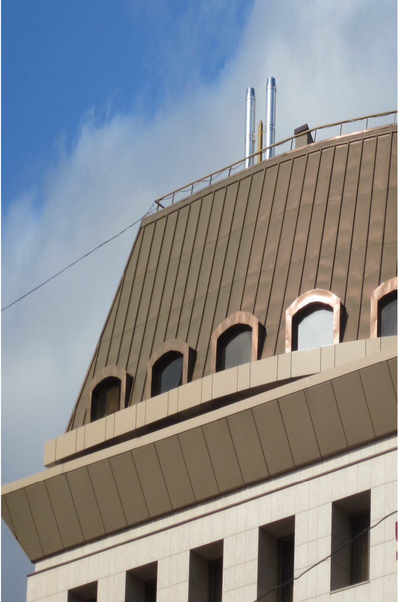
Рисунок 12 – Покрівля з покрівельної міді
