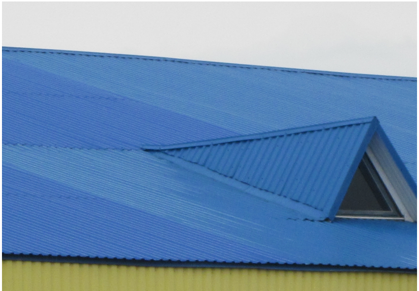
Рисунок 16 - Покрівля з профнастилу
