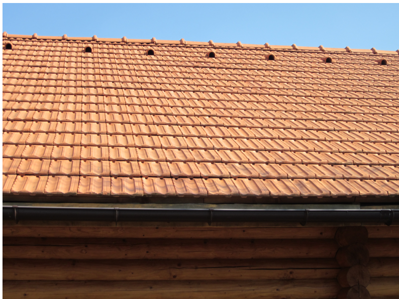
Рисунок 5 – Покрівля з цементно-піщаної черепиці
