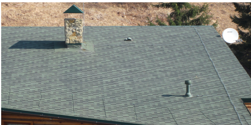
Рисунок 8 – Покрівлі з бітумної черепиці
