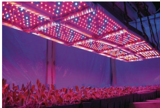
Рисунок 1.4 – Система штучного освітлення теплиці
