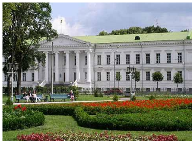
Рисунок 1.48 – Адміністративна будівля у м. Полтава
