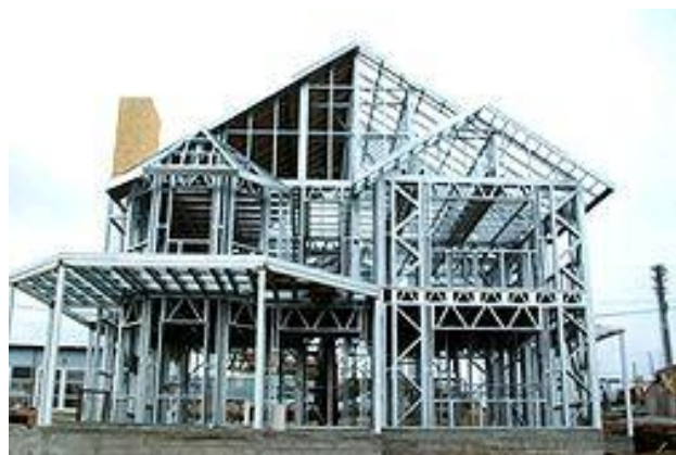
Рисунок 2.32 – Каркас будівлі з легких сталевих конструкцій
