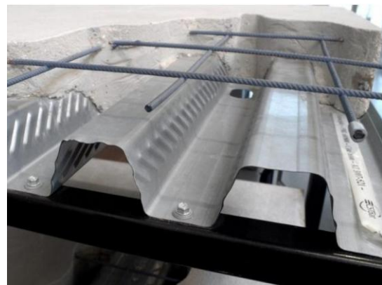
Рисунок 2.33 – Незнімна опалубка з пінопластових блоків та з профільованого настилу
