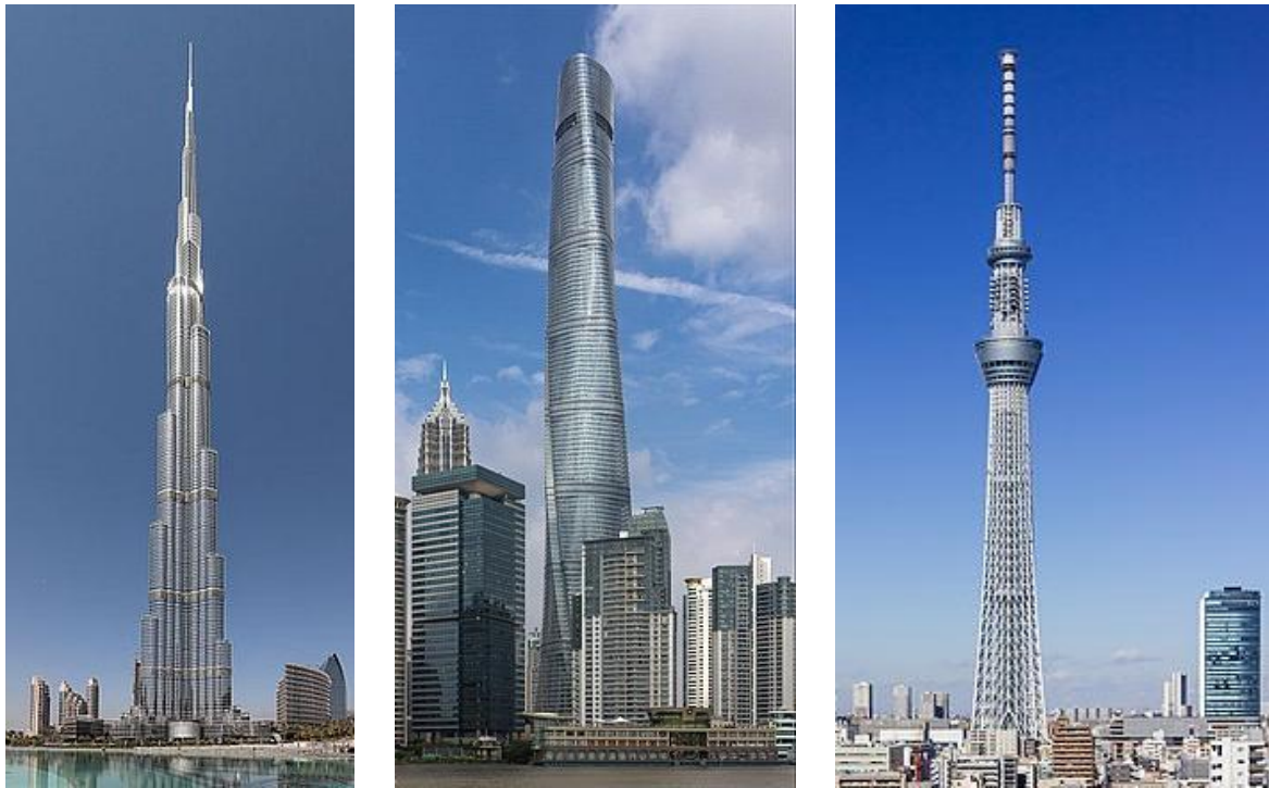
Рисунок 2.37 – Бурдж Халіфа, Шанхайська башта, Токійське небесне дерево
