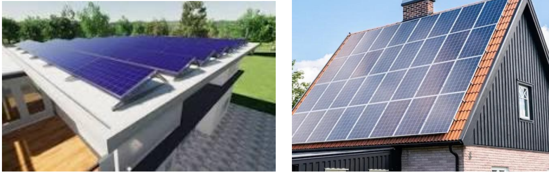
Рисунок 2.35 – Сонячні панелі на плоскому та похилому даху будівлі
