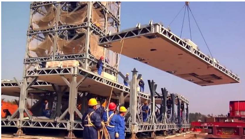
Рисунок 2.31 – монтаж модуля перекриття і загальний вигляд будівлі "Т30 Hotel"
