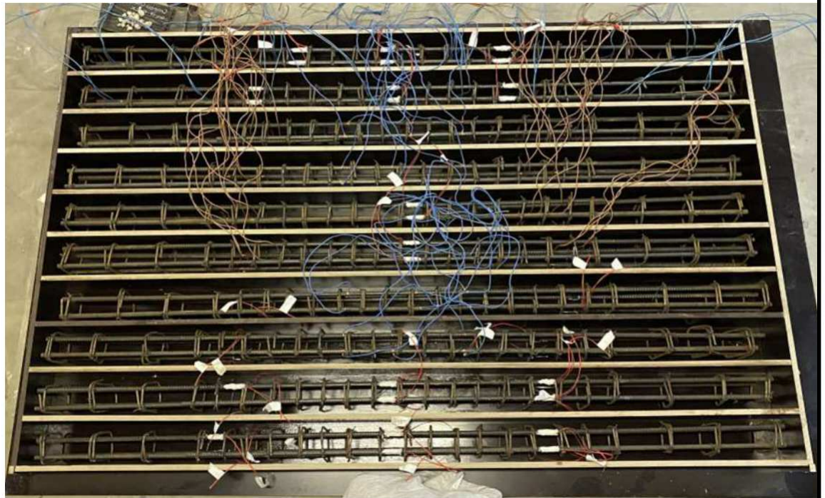
Рисунок 7 - Арматурні каркаси в опалубці
