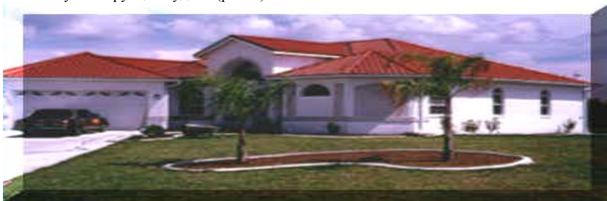
Рисунок 1 – Загальний вигляд будинку з пінополістірольних блоків
