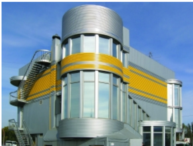
Рисунок 3 – Внешний вид обшивки здания НВФ
