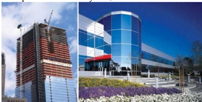
Рисунок 2 – Примеры зданий с отделочным фасадом
