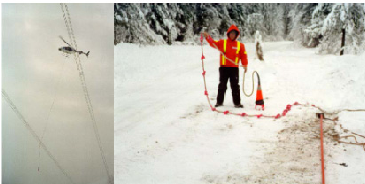
Рисунок 1.6 – Механічне видалення ожеледі з ПЛ за допомогою гелікоптера [10]
