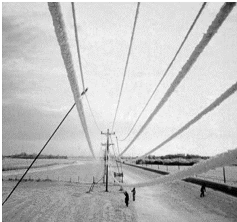
Рисунок 2.2 – Кристалічна паморозь на ПЛ [14]
