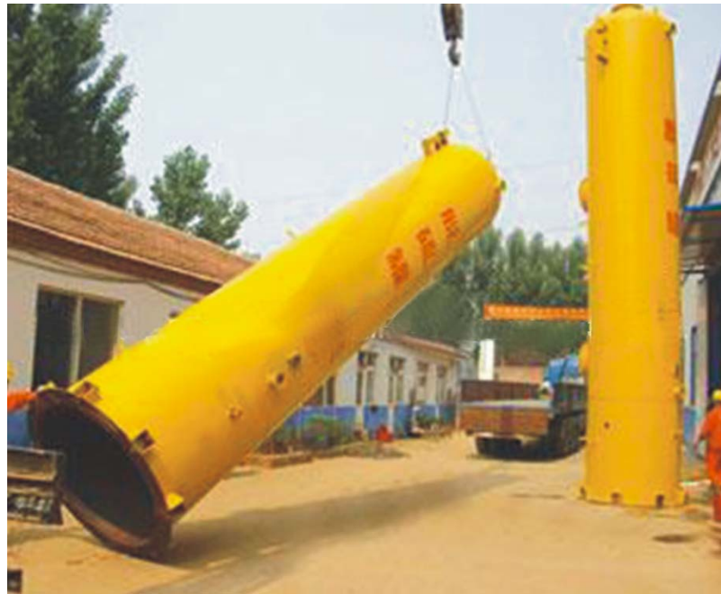
Рис. 3.4. Загальний вигляд колонок для очищення біогазу від сірководню
