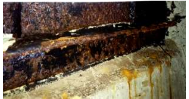
Рисунок 2.4.10. Конденсована під дахом волога, іржа, руйнування конструкцій
