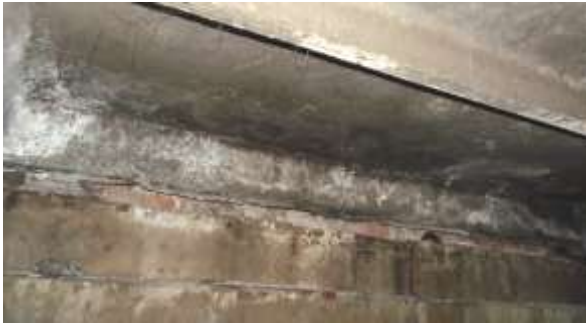
Рисунок 2.4.10. Конденсована під дахом волога, іржа, руйнування конструкцій
