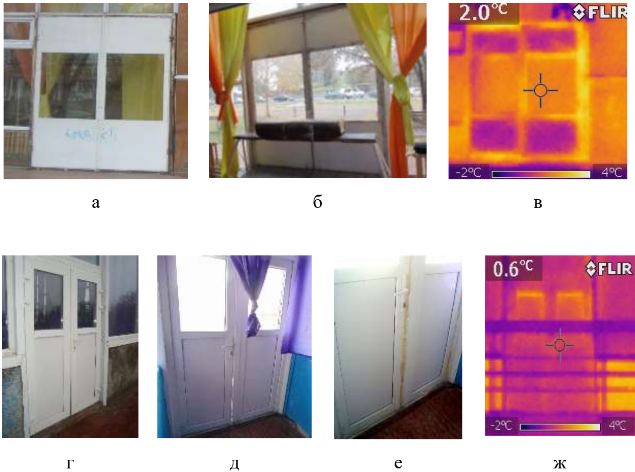
Рисунок 2.4.5. Двостулкові двері аварійного виходу:
