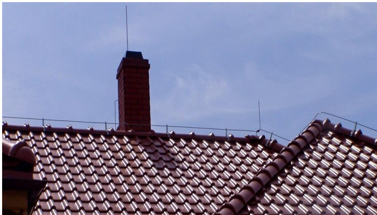
Рис. 2.1. Зовнішній блискавкозахист приватного будинку.
