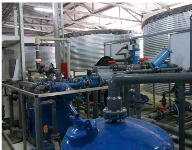
Рис. 2.2 – Зовнішній вигляд вузла системи краплинного поливу FD-326D
