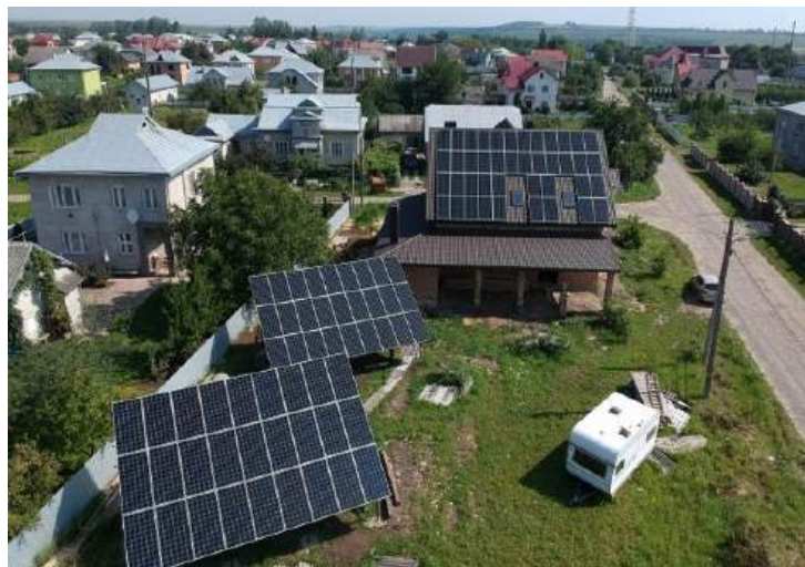
Рисунок 2.7 – Сонячні панелі на будівлях
