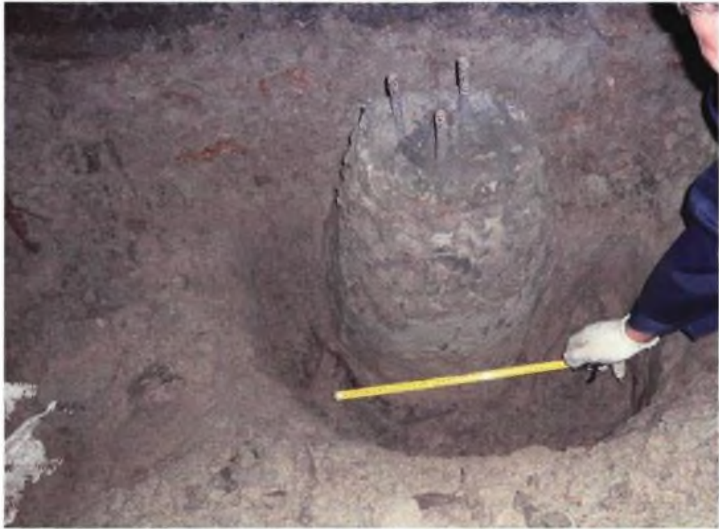
Рис. 3.13. Вимірювання діаметра мікропалі на відм. -0.8
