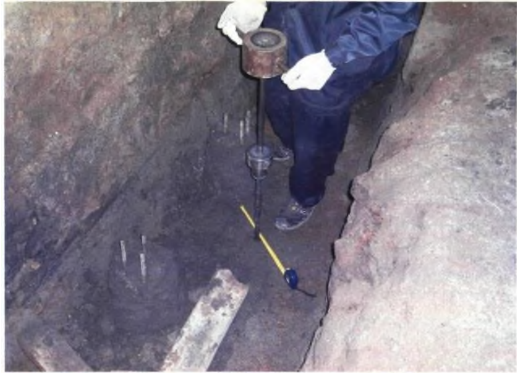
Рис. 3.6. Динамічне зондування ґрунтів основи в навколопальовому просторі.
