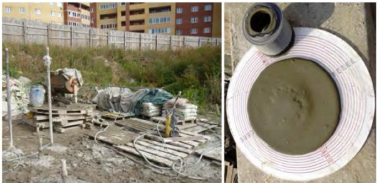
Рисунок 3.3 – Приготування глиноцементного розчину
