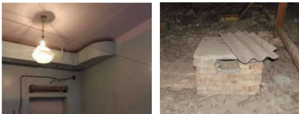
Рисунок 3.3 – Зовнішній стан елементів системи вентиляції
