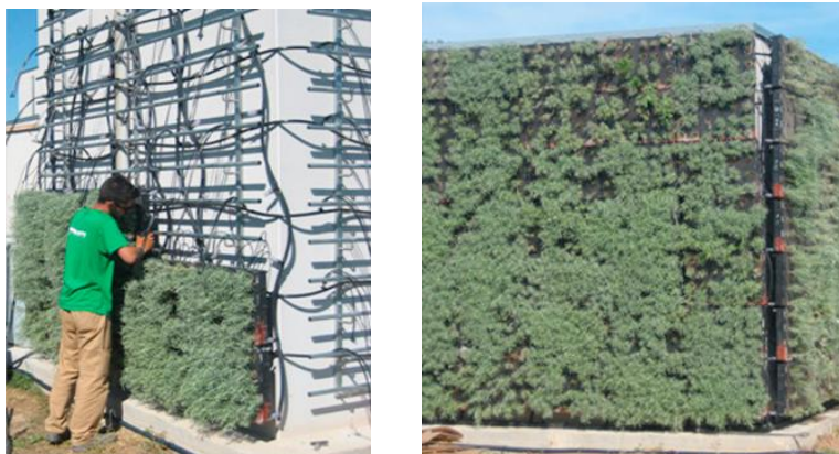
Рис. 5. Живі стіни. Панелі. Puigverd de Lleida, Іспанія.
