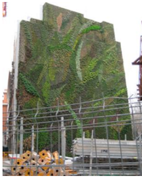
Рис. 6. Живі стіни. Геотекстильний фетр. Мадрид, Іспанія.
