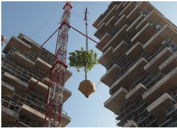
Рис. 11. Процес будівництва комплексу і висаджування дерев.
