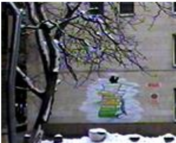
Рисунок 2.6. Збільшені теплові втрати через стіну біля фундаменту, та де закладено отвори забірників повітря
