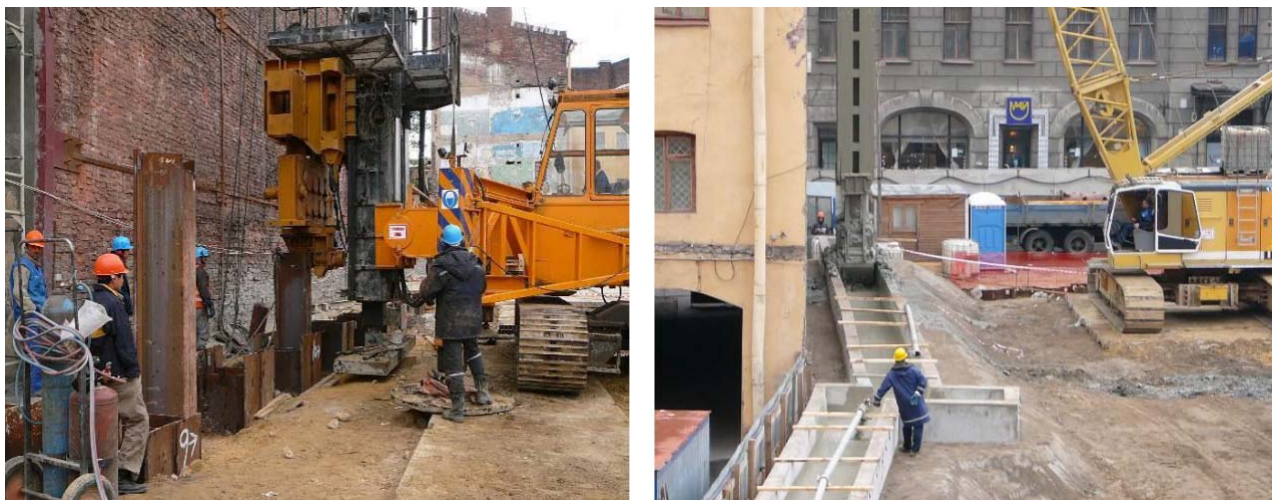
Рисунок 1.2 - Занурення шпунта й влаштування «стіни в ґрунті» біля існуючих будівель на об'єкті «Подільський»
