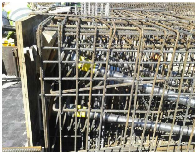
Рисунок 1.4 - Укладання гофрованих труб для канатів постнапруження
