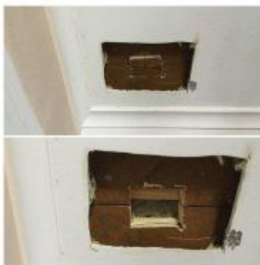
Рис. 2.6 – Розтин шару покрівлі з шпунтових дошок
