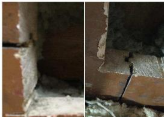
Рис. 2.7 – Наявність щілин і зазорів між настилем із шпунтових дошок
