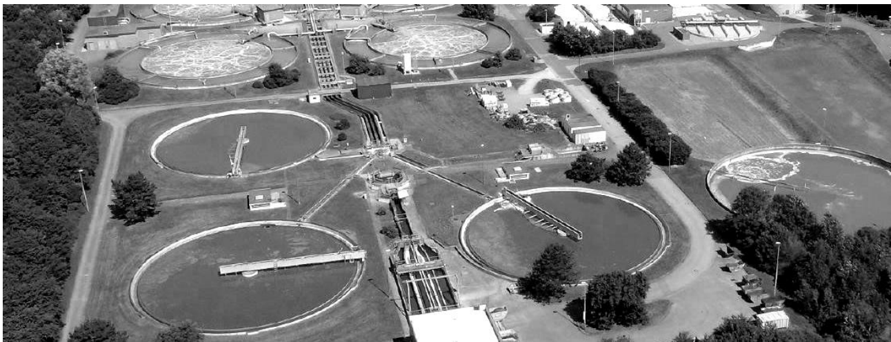
Рис. 1.1 – Відстійники – споруди, де утворюється осад від очищення стічних вод
