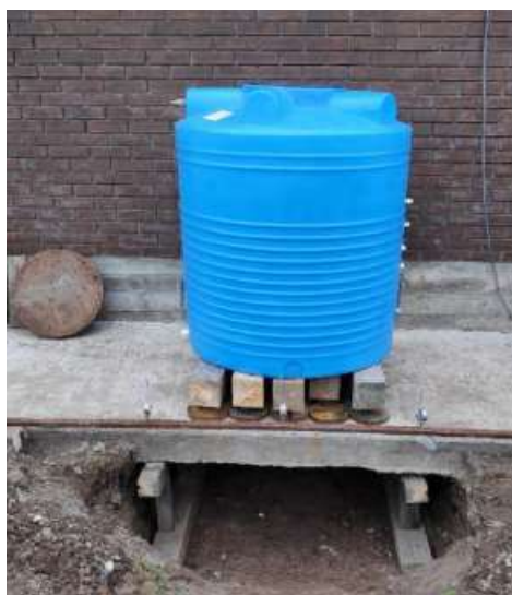
Рисунок 2.12 – Встановлення ємності об'ємом 1 м.
