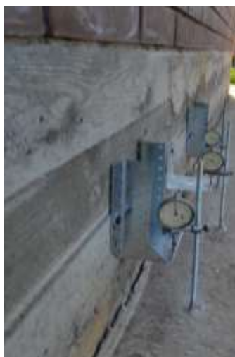
Рисунок 2.7 – Індикатори годинникового типу, зафіксовані на вимощенні та стіні будівлі ТОЦ.
