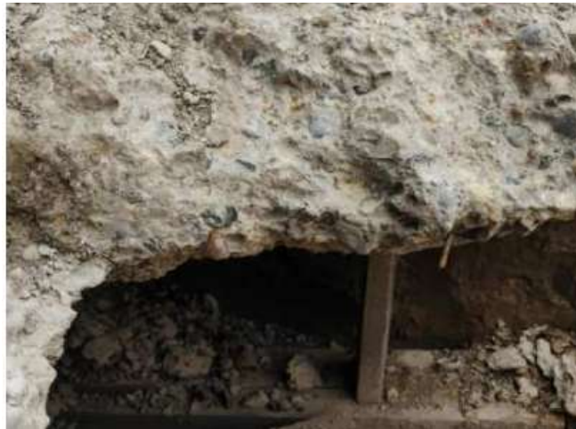
Рисунок 2.21 – Загальний вигляд армування шару бетону кладочною сіткою 3мм.
