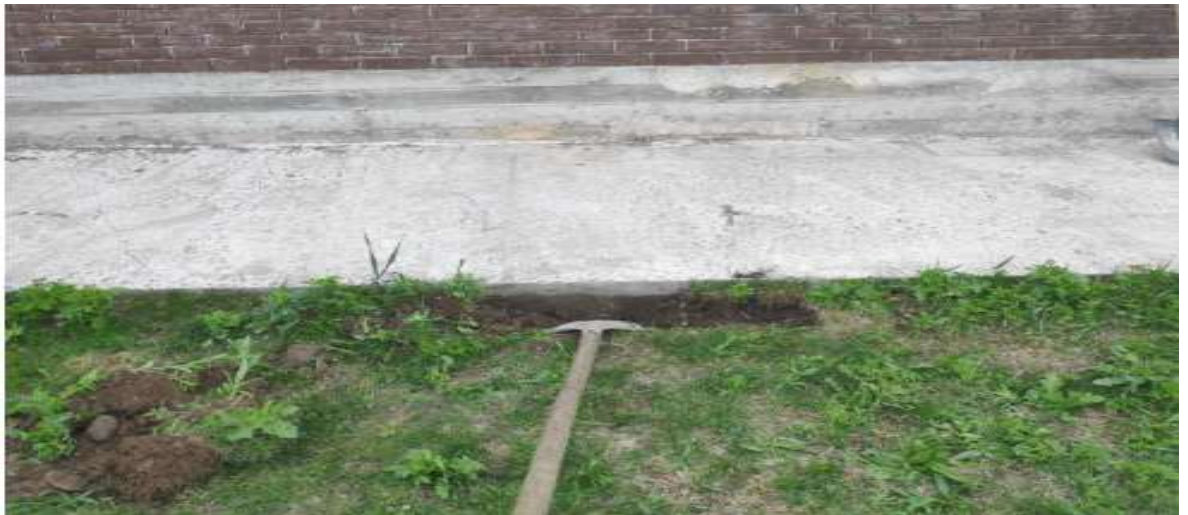
Рисунок 2.4 – Бетонне вимощення навколо будівлі до початку робіт.
