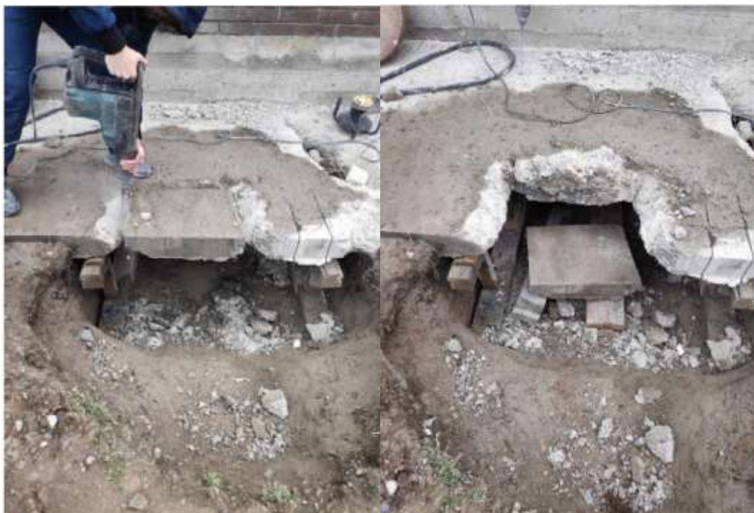
Рисунок 2.18 – Процес демонтажу бетонного масиву.
