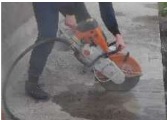
Рисунок 2.17 – Пропилювання бетонного масиву
