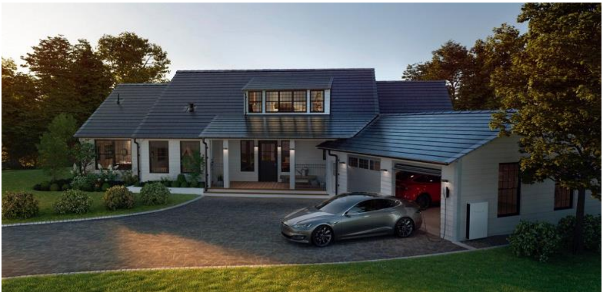
Рис.24. Покрівля котеджу черепицею Solar Roof
