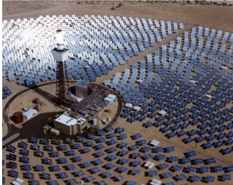
Рис. 41. Розміщення 1926 геліостатів загальною площею 83000 \text{ м}^2 відносно сонячної башти на сонячній термодинамічній електростанції «Solar Two» в пустелі Мохаве (Каліфорнія, США)
