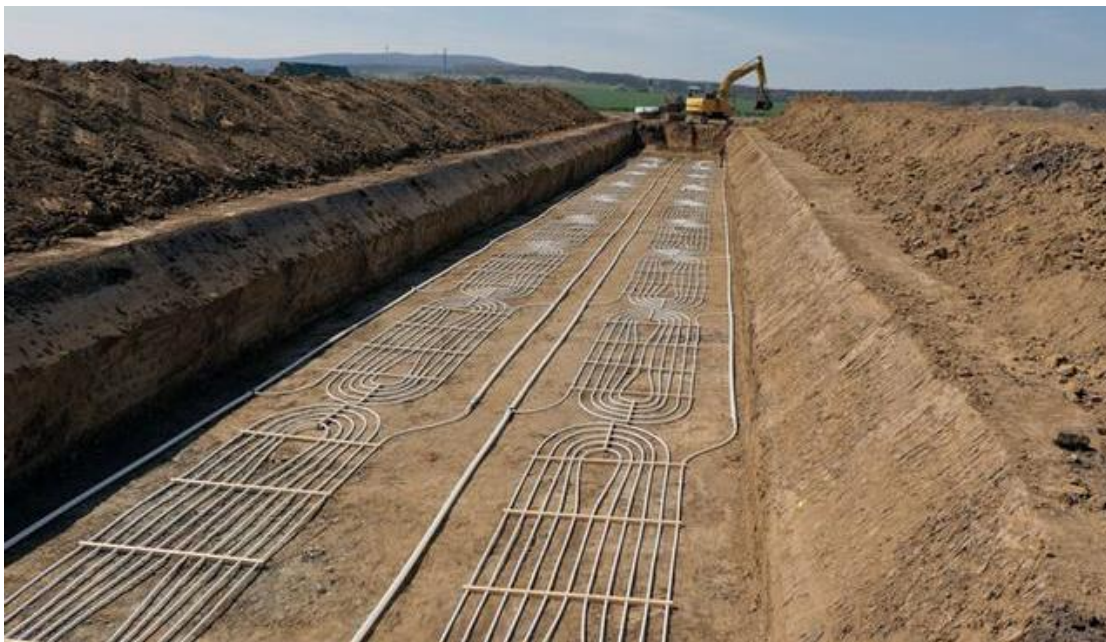
Рис.129. Укладання ґрунтового колектора
