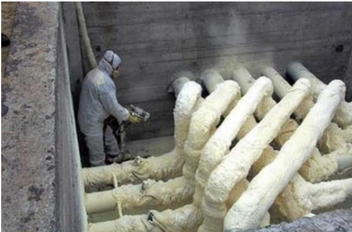
Рис.104. Нанесення теплоізолюючого пінополіуретанового шару на труби теплової мережі
