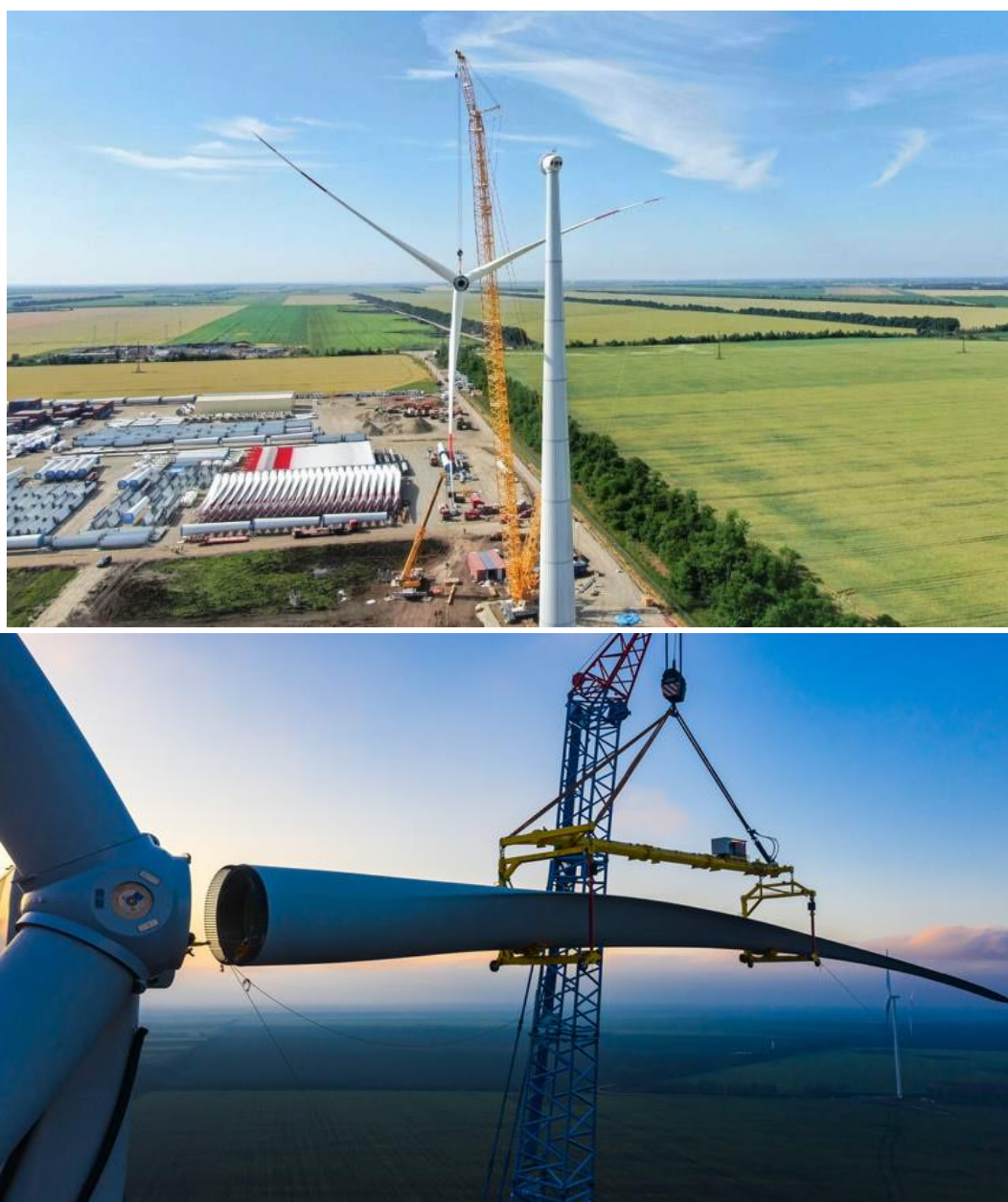
Рис. 55. Встановлення лопатей на вітрогенератор
