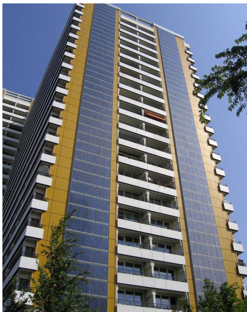
Рис. 20. Розміщення сонячних батарей на південному фасаді багатоповерхової будівлі
