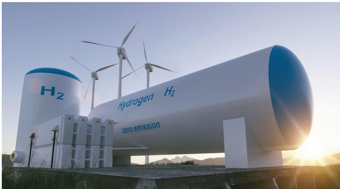
Рис. 67. Станція по виробництву зеленого водню
