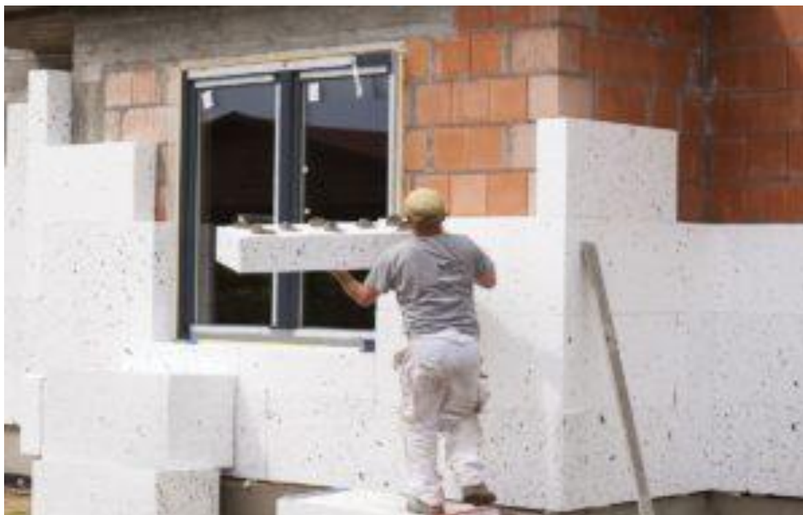
Рис.102. Утеплення стін спіненим полістиролом
