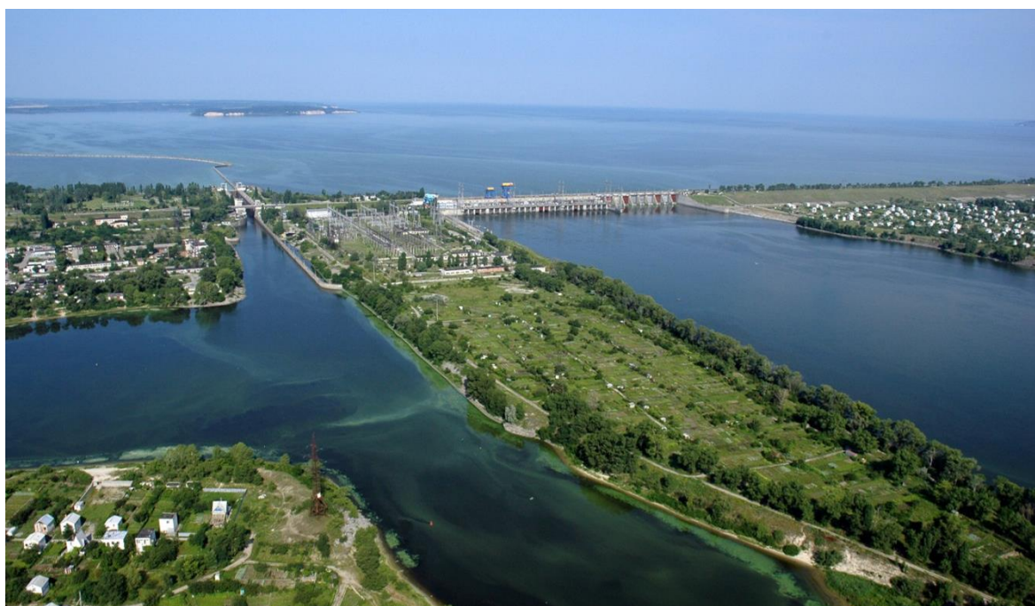
Рис. 5. Кременчуцька гідравлічна електростанція
