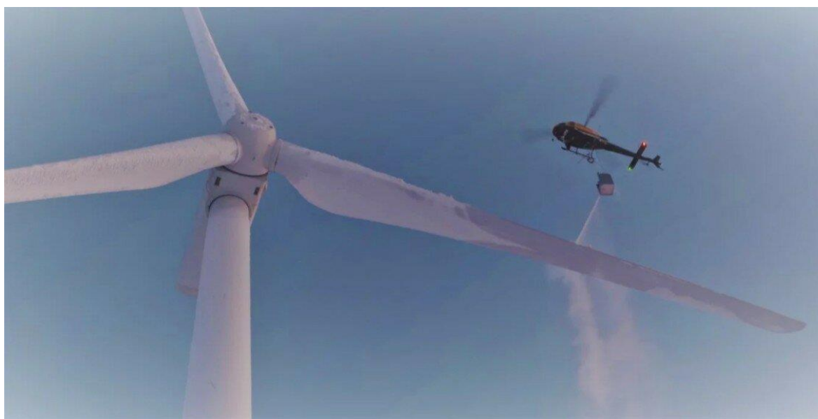
Рис. 56. Обробка з гвинтокрила лопатей лопатей вітрогенератора проти обледеніння
