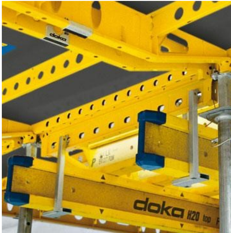
Рисунок 2.11 Щитова опалубка перекриття Dokadek30
