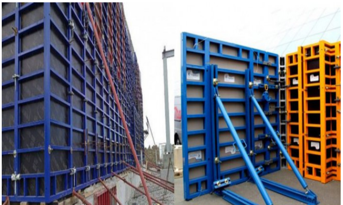
Рисунок 2.6 Під'ємно переставна опалубка
