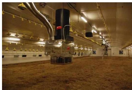
Рисунок 1.6 – Приклад використання газового нагрівача повітряної системи серії IFH 45 кВт обігріву на птахоферми
