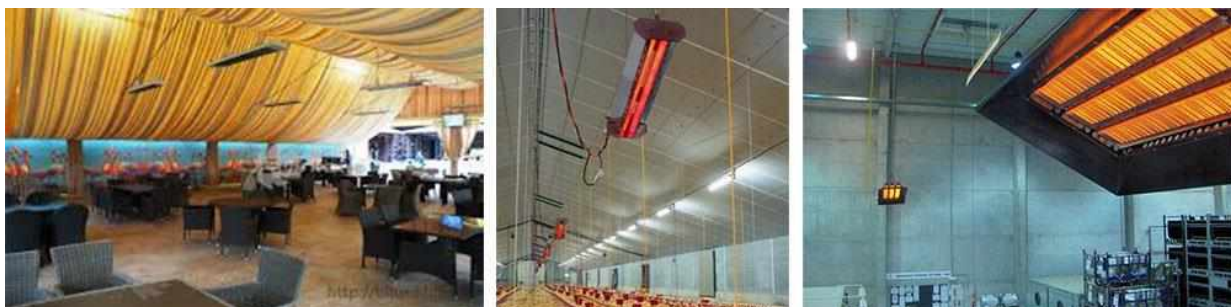
Рисунок 1.8 - Обігрів виробничих приміщень інфрачервоним нагрівачем
